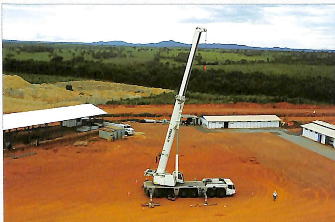
Guindaste de 250 t da Terex vai operar na Mineração Maracá, em Novo Horizonte (GO)
