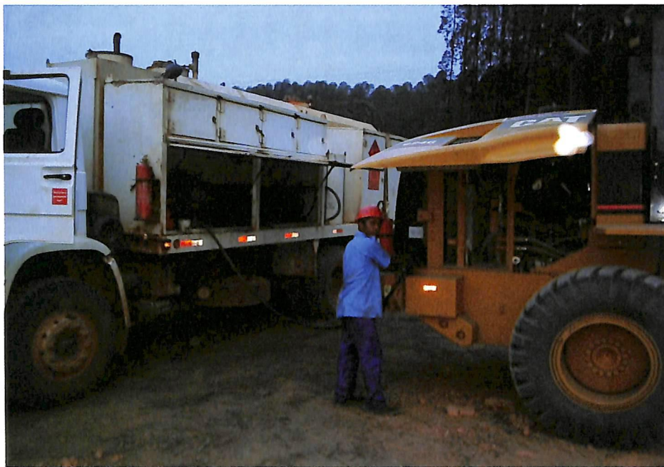
Lubrificação in loco : Comboio vai até o local onde máquinas operam
