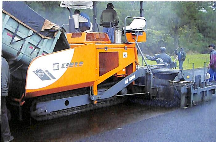
Novo vibro acabadora AF 5000: pavimentação de 5,3 m de largura.
