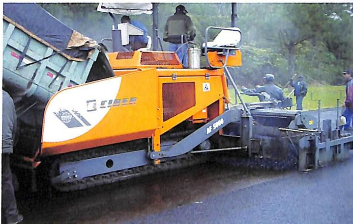
Novo vibro acabadora AF 5000; pavimentação de 5,3 m de largura.
