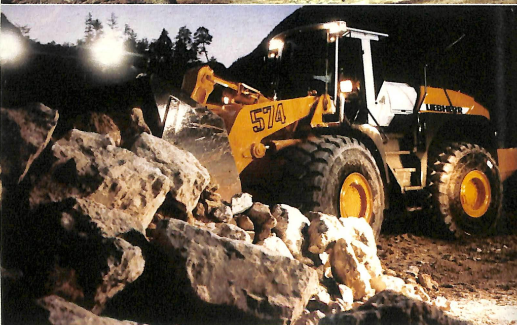
Obras utilizam 16 escavadeiras Liebherr (entre as quais a 954) e sete carregadeiras L574
