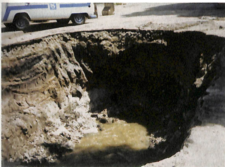
Colapso total de um coletor de esgoto com muitos anos de uso.
