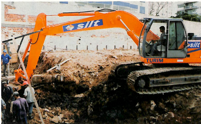
A obra típica: escavação para fundações prediais
