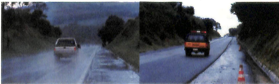
Pista molhada da Rodovia das Cataratas (PR), com cimento asfáltico convencional e após a aplicação de Befuflex®, asfalto modificado com polímero.
