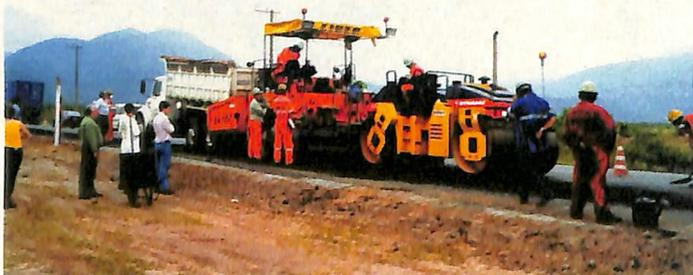
Em seguida os estudantes visitaram o pátio de equipamentos locados na obra, as oficinas de manutenção dos equipamentos, a usina de asfalto certificada pela ISO-9000, o laboratório de análise de asfalto, e a acabadora de asfalto em operação no trecho da Rodovia, juntamente com rolo compactador vibratório de chapa e
