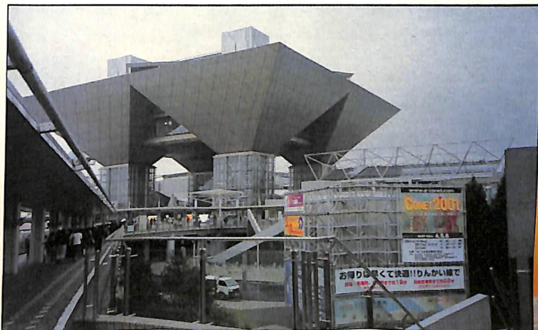
Parque de exposições construído sobre aterro no litoral Parque de exposiciones ubicada sobre terrenos ganados al mar
