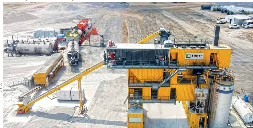
Sistemas utilizam a leitura dos gases de saída para auxiliar no gerenciamento da relação entre ar e combustível
