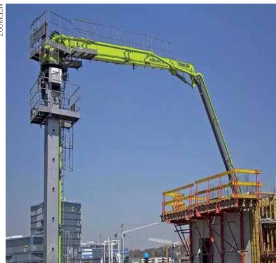
Ação da gravidade pode comprometer a homogeneidade do concreto durante o percurso pela tubulação
