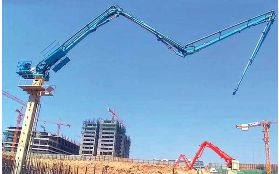
Conhecido como placing boom , braço independente recebe e distribui o concreto sobre a laje
