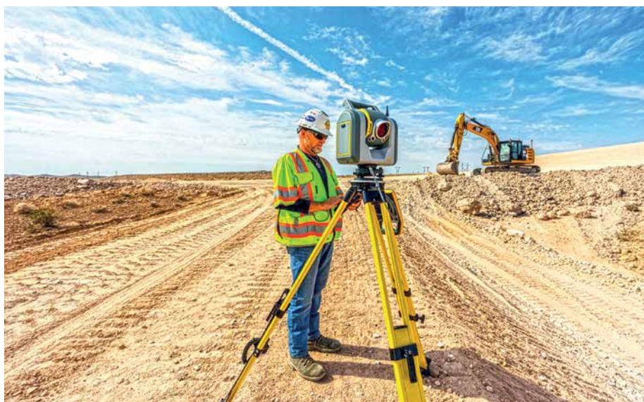
Estações Totais Robóticas fornecem referência topográfica de alta precisão para a máquina
