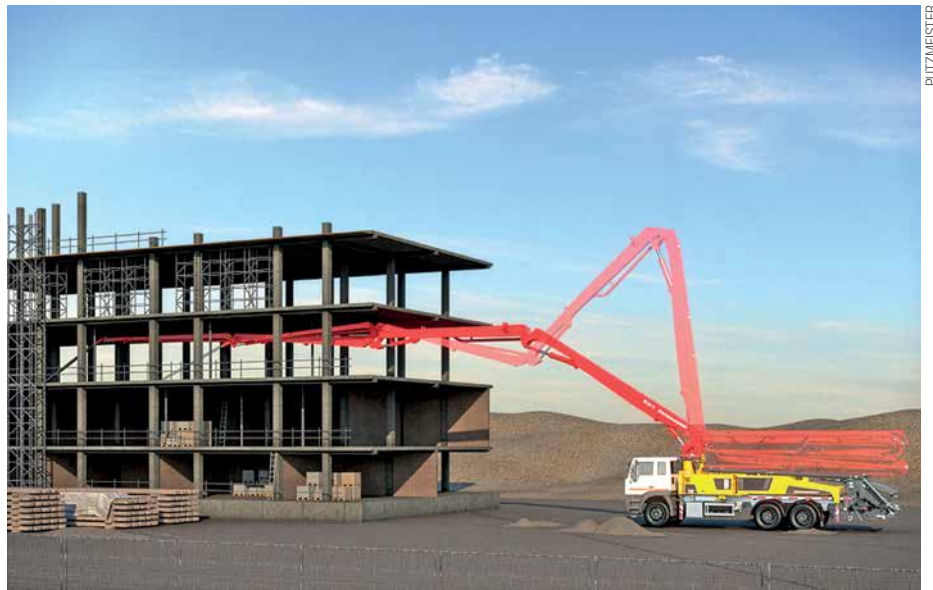
Evolução dos traços exige vazões e pressões maiores para dar conta de entregar concreto a grandes alturas e distâncias, com versatilidade no bombeamento
