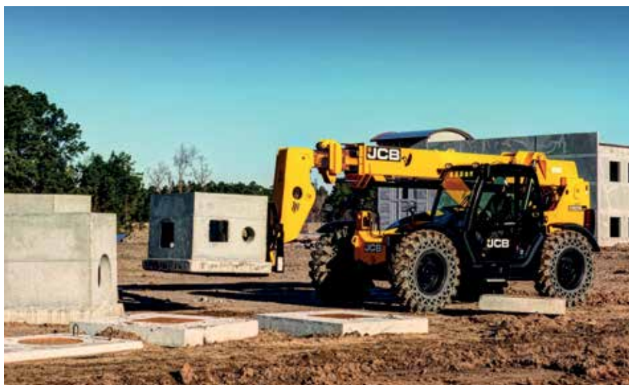
Agilidade para operar em terrenos irregulares torna a máquina capaz de substituir outros equipamentos
