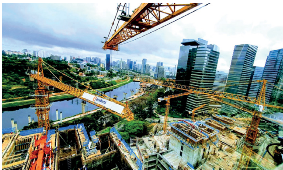
Ancoragem do equipamento é praticamente indispensável em obras com mais de dez pavimentos
