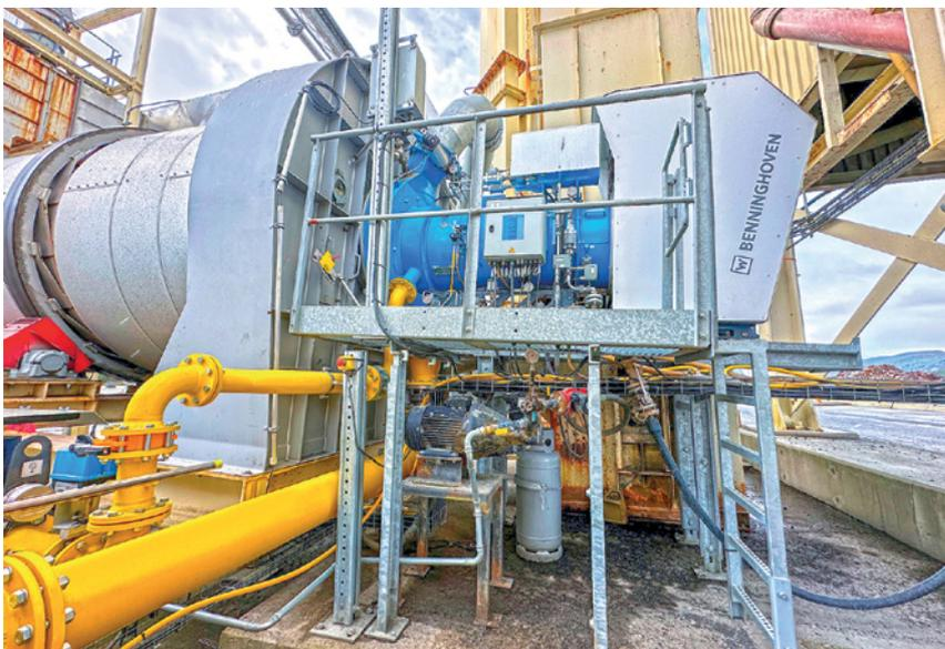
**Queimador Multi Jet** é capaz de utilizar até quatro combustíveis como fonte de energia, incluindo hidrogênio
