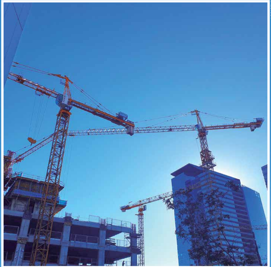
Características estruturais são relevantes onde existe mais de uma grua trabalhado, evitando a interferência entre as lanças
