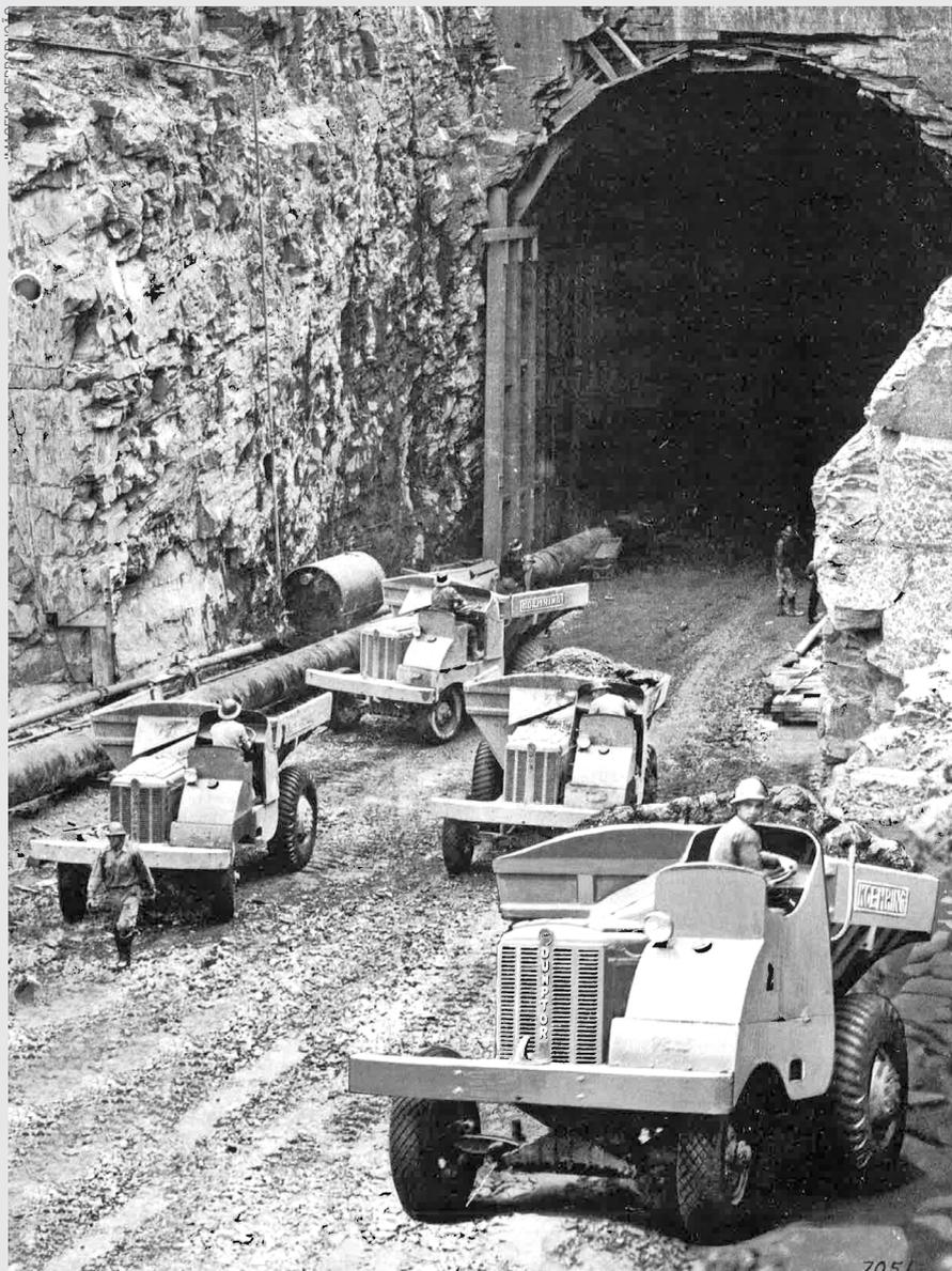
Na década de 40, os Dumptors da Koehring iniciaram uma tradição na linha de equipamentos para transporte de material escavado
