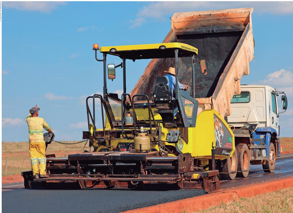
Sapatas de redução e extensão permitem ajustes na largura de pavimentação
