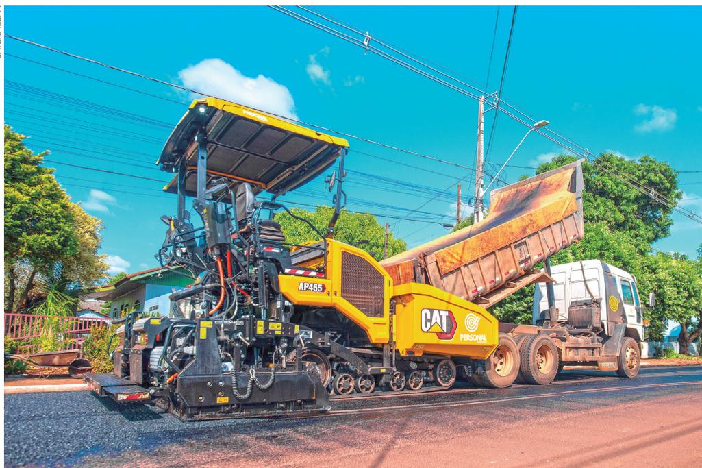
**Sistemas de vibração e tamper** ajudam a aumentar a densidade da camada de asfalto
