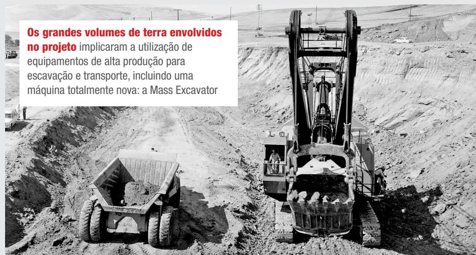
**Os grandes volumes de terra envolvidos no projeto** implicaram a utilização de equipamentos de alta produção para escavação e transporte, incluindo uma máquina totalmente nova: a Mass Excavator
