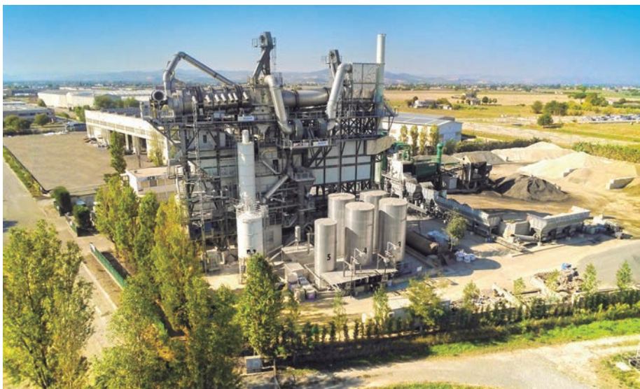
Já em uso na Europa, usinas da linha TRX são capazes de produzir asfalto com até 100% de RAP
