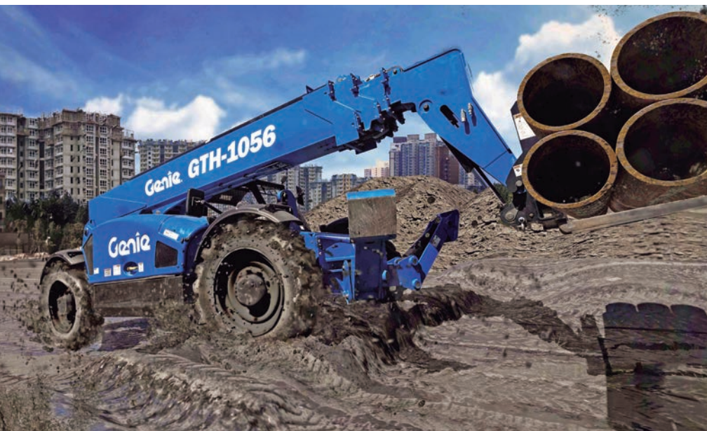
Em deslocamentos , a carga deve ser mantida o mais próximo possível do solo, com a lança retraída no limite
