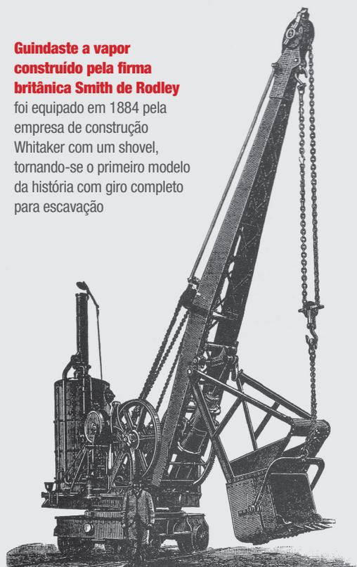
**Guindaste a vapor construído pela firma britânica Smith de Rodley** foi equipado em 1884 pela empresa de construção Whitaker com um shovel, tornando-se o primeiro modelo da história com giro completo para escavação
