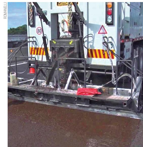
**Mistura de microrrevestimento asfáltico** a frio permite espalhamento mais uniforme
