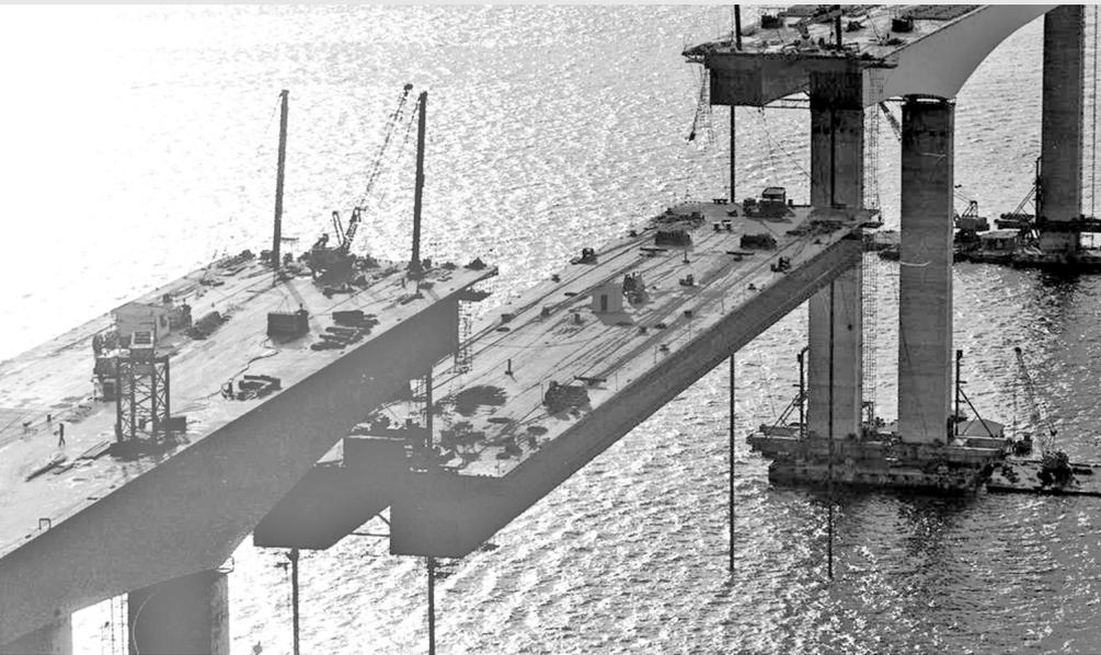
**Seções do vão central** foram içadas até o topo dos pilares por macacos hidráulicos
