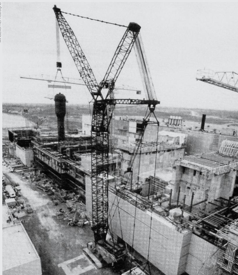
**Lançado em 1981**, o guindaste de esteira Liebherr LR 1600 contava com luffing derrick e lastro suspenso de 730 ton, com momento de carga chegando a 18.000 ton.m
