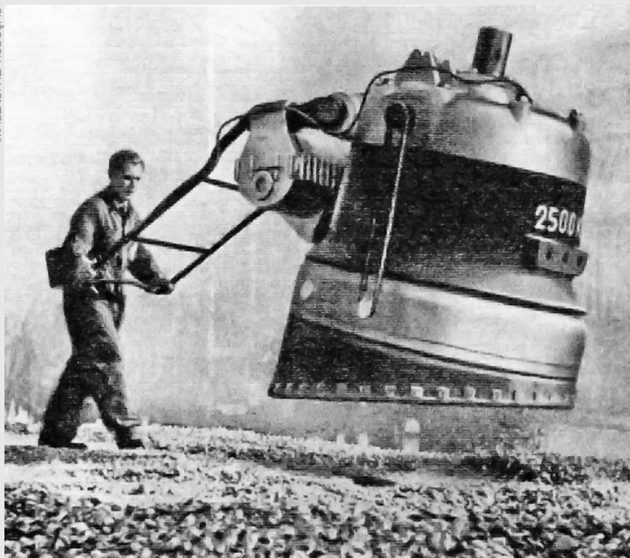
Com peso de 1 ton, o modelo Delmag 1000 foi o maior compactador de impacto já construído
