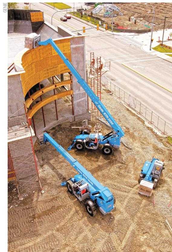
**Configuração do equipamento** deriva da análise do peso e do centro de gravidade da carga
