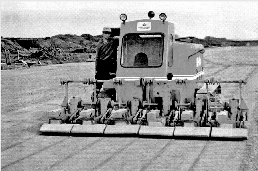
Com 95 hp e 8 ton, a placa vibratória O&K RV12A utilizava até seis placas montadas na frente
