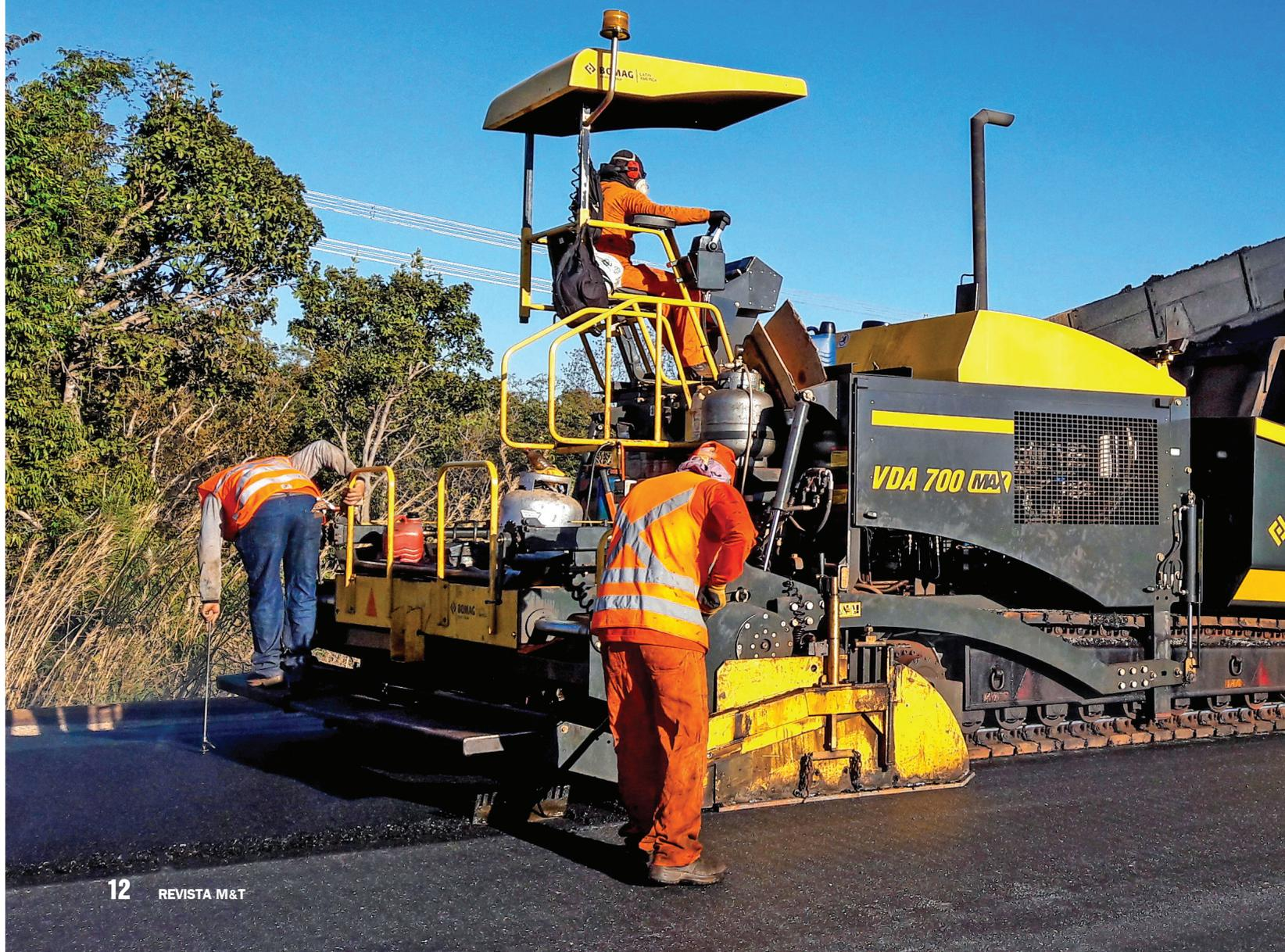
**T**ambém conhecidas como pavimentadoras de asfalto, as vibroacabadoras exercem um papel essencial na aplicação, nivelamento e pré-compactação do asfalto em obras de pavimentação. Até aí, sem novidades.
