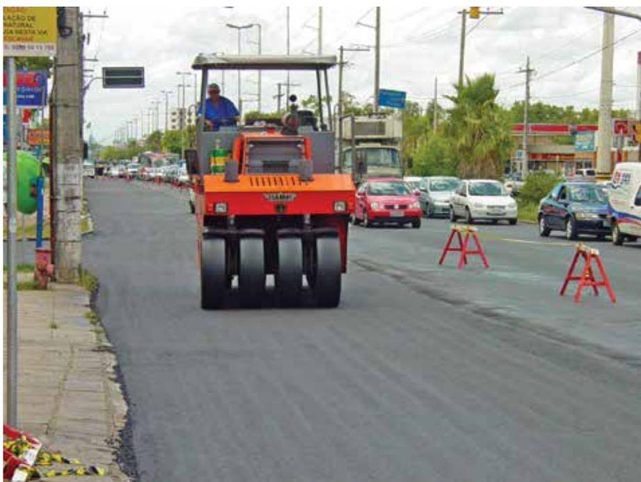
**Sobrepasso insuficiente** é um dos fatores recorrentes que podem comprometer a qualidade do pavimento
