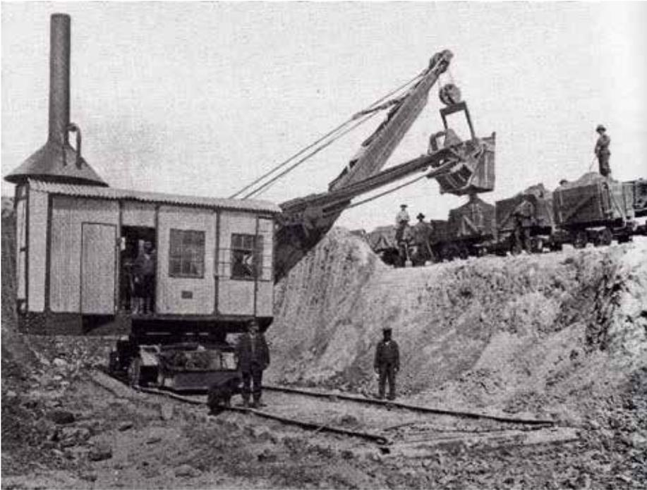
**Além de portar descarga ajustável, o shovel O&K 16** possuía um único motor a vapor para todas as funções
