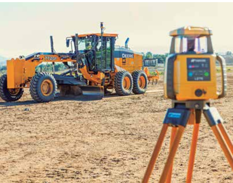
Embratop destaca o sistema de automação da Topcon para máquinas de terraplenagem e pavimentação
