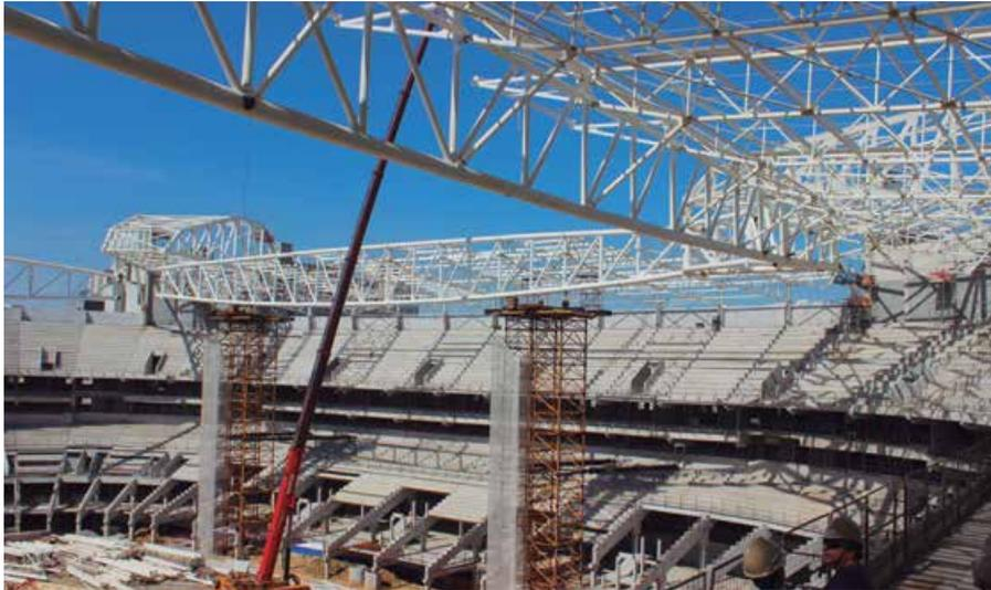
Montagem da cobertura exigiu a instalação de cinco módulos com 160 t cada
