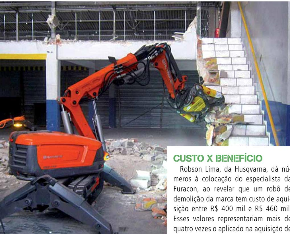
Máquina realiza demolições controladas
