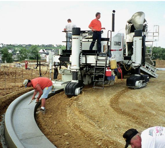
Máquina automatiza a construção de sarjetas
