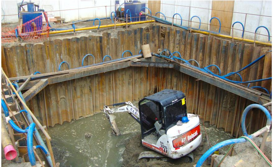
Uso de estacas-prancha: facilitou a escavação das estações elevatórias
