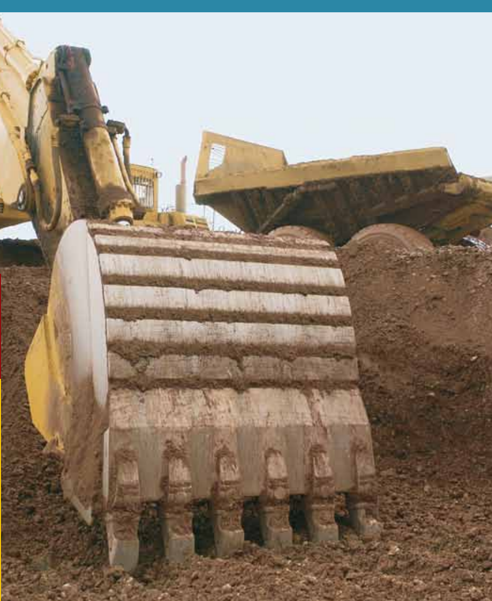
Lâminas retas já não são as únicas disponíveis para escavadeiras
