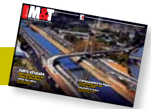
Capa: Imagem aérea das obras da Ponte Estaiada da Marginal Tietê (Foto: EIT).
