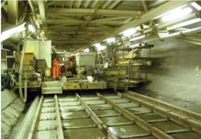
Trem de concretagem faz o acabamento do túnel
