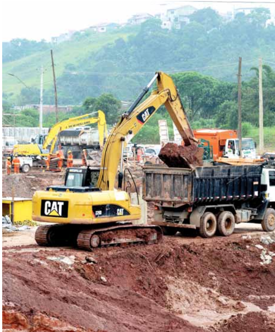
Equipamentos precisam ser transportados constantemente de um ponto ao outro da obra
