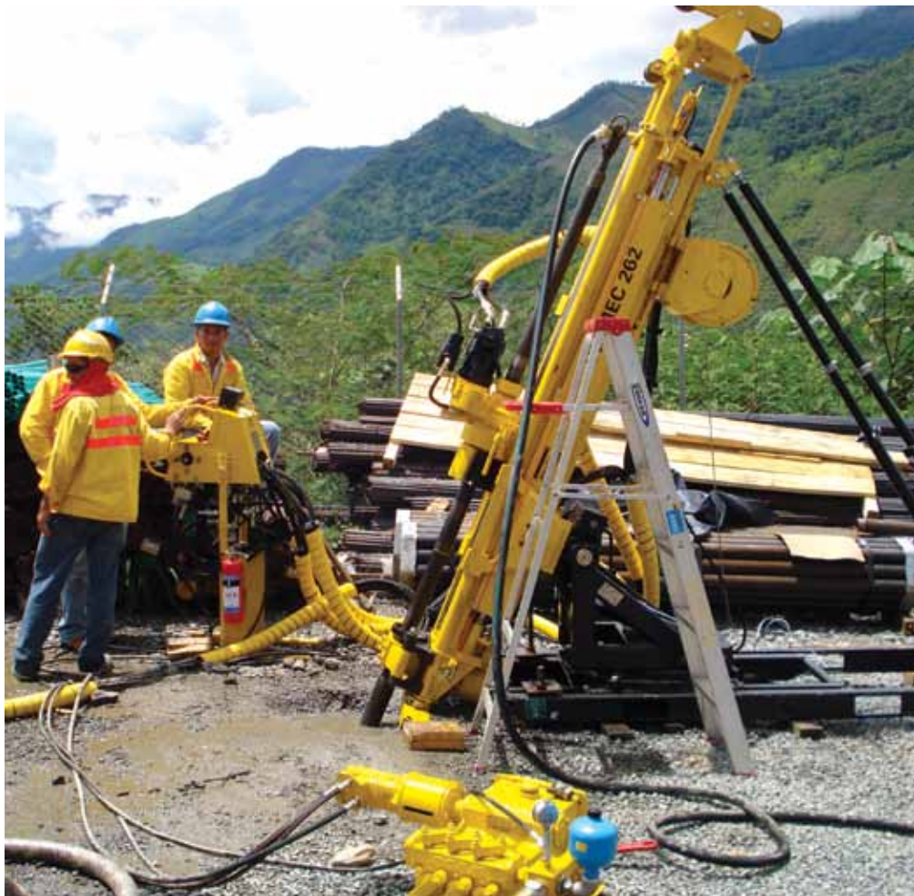
Sondagem STP avançou com a mecanização
