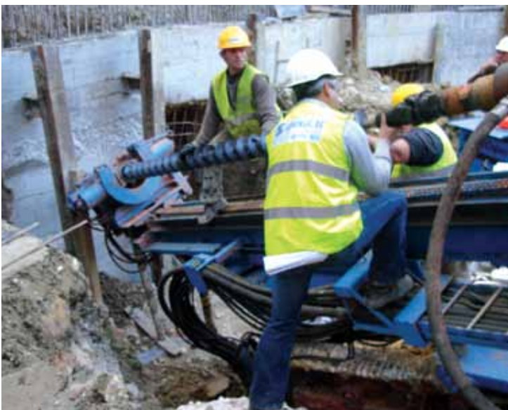
Qualidade do trado e geometria das aletas influem na sondagem
