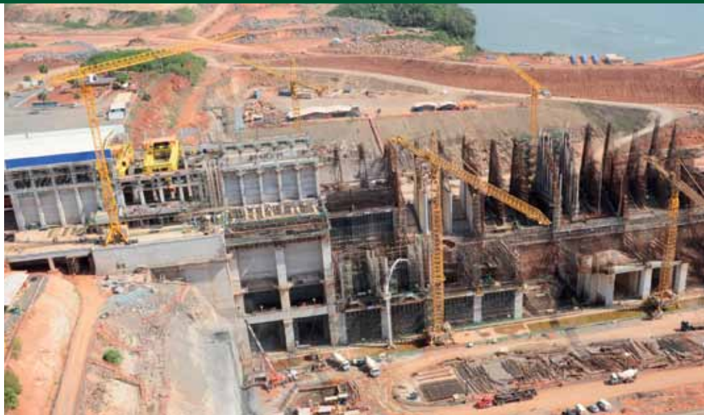
Sistema impede o giro de uma grua sobre a outra
